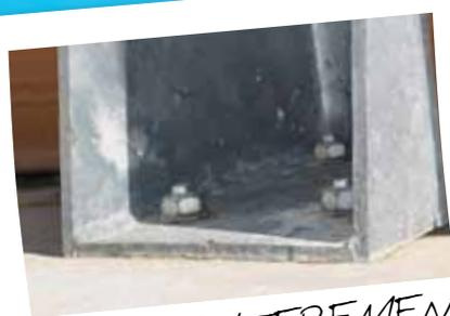
*Enfoncez ENTIEREMENT les gougeons d'ancrage (seule la tête doit rester visible).*
