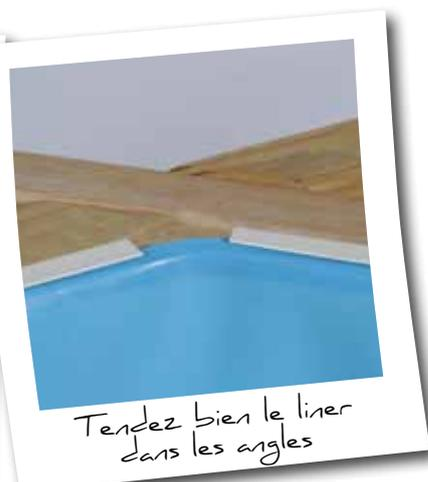
Une fois le liner mis en place, continuez à remplir la piscine jusqu'à 10 cm sous la buse de refoulement.
